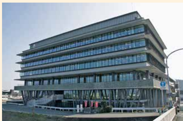
建設中の新庁舎
