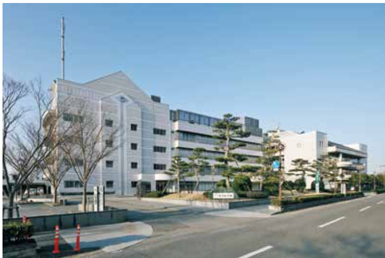
災害時に地域防災の拠点となる松茂町役場 (平成29年3月に、耐震改修工事が完了)
